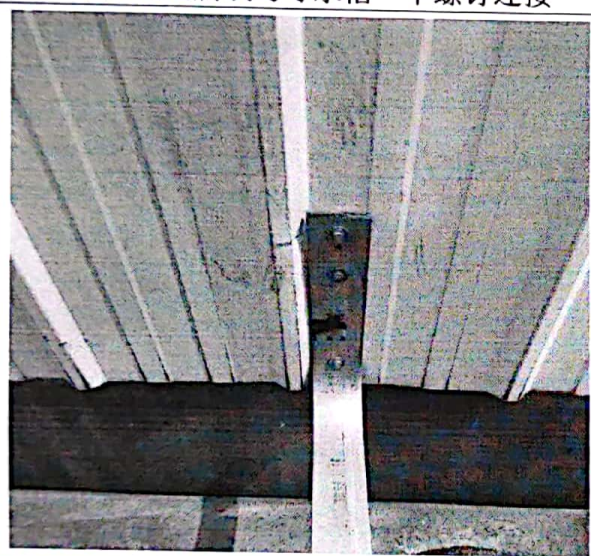
个别屋面接地扁有锈蚀
