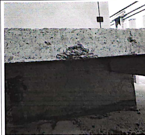
个别箱变等设备基础表面粗糙、边角不整齐
