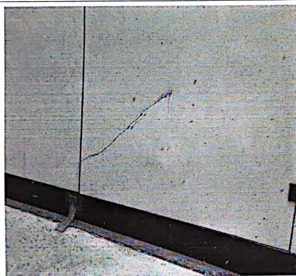
个别箱变设备表面漆有划痕，表面有泥污
