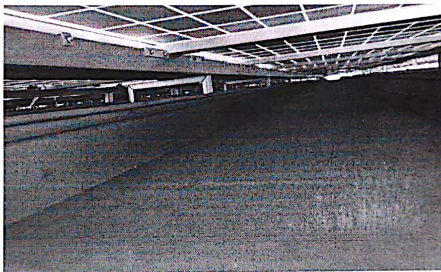
组件下方垃圾已清理
