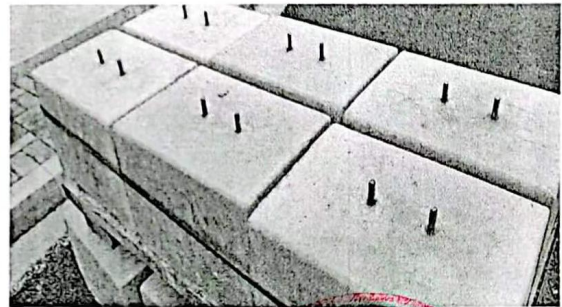
新进场待更换前支墩
