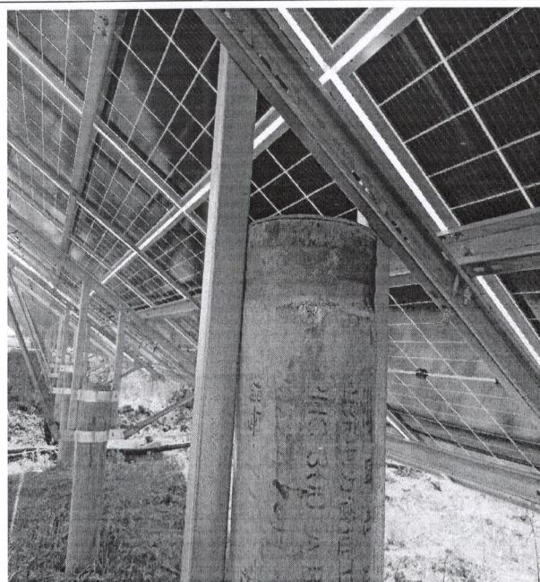
管桩桩帽为除锈、防腐
