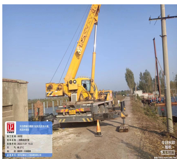
吊装区域未设置警示带、大臂下及转弯半径内站人
