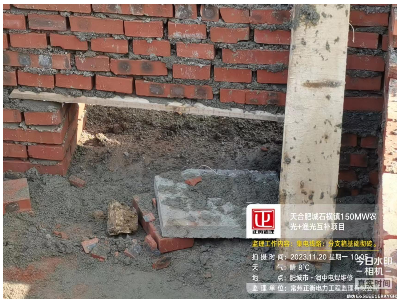
过梁使用木板
