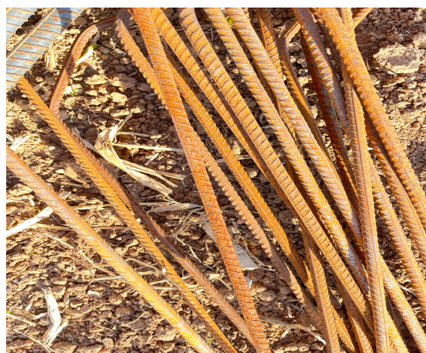
外箍筋锈绣严重
