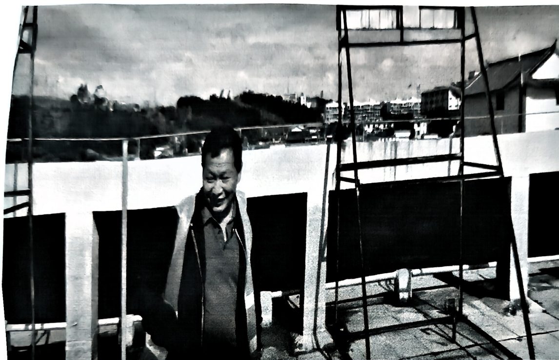
施工人员未佩戴安全帽
