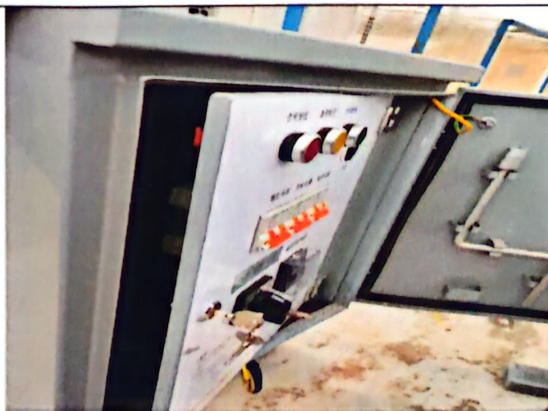
6. SVG 接地线脱落要求整改
