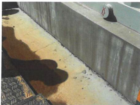
11、一次舱散水开裂且无排水措施
