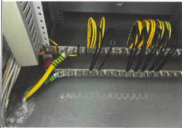
5、二次盘柜内接地排连接至等电位接地网上
