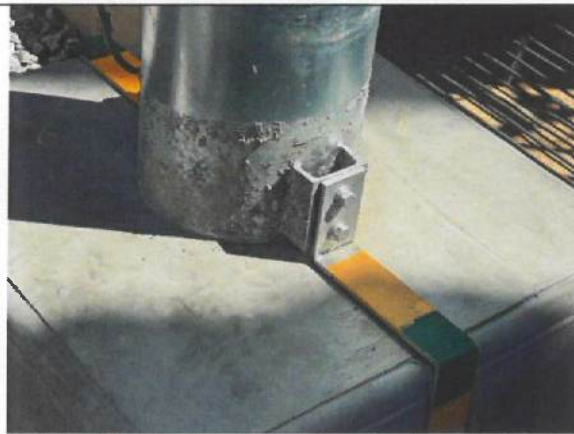
12、主变检修箱接地连接至等电位接地网
