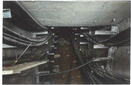
18、电缆沟内建筑垃圾未清理
