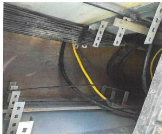
12、主变检修箱接地连接至等电位接地网
