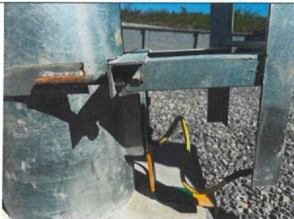
7、GIS 211-A0 接线套管螺丝错位
