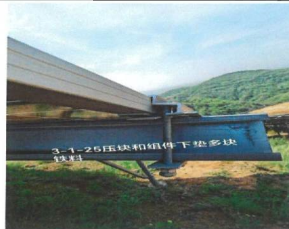
30、压块和组件下垫多块铁料
