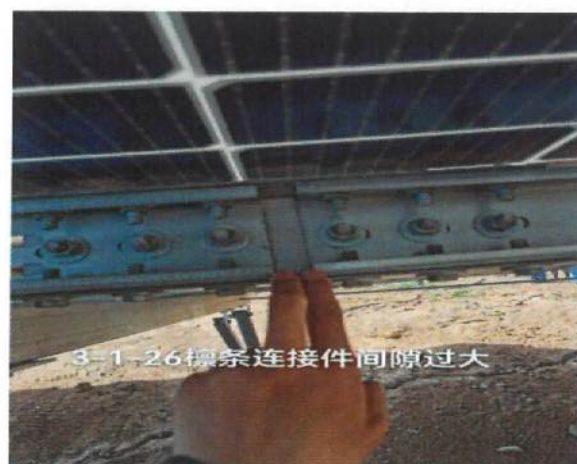
21、檩条连接件间隙过大
