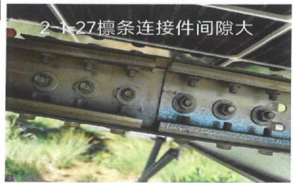
18、檩条连接件间隙大
