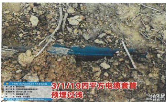
41、四平方电缆套管预埋过线
