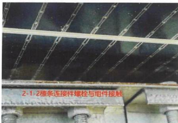
83、檩条连接件螺栓与组件接触
