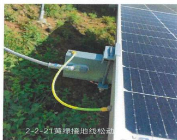
114、黄绿接地线松动
