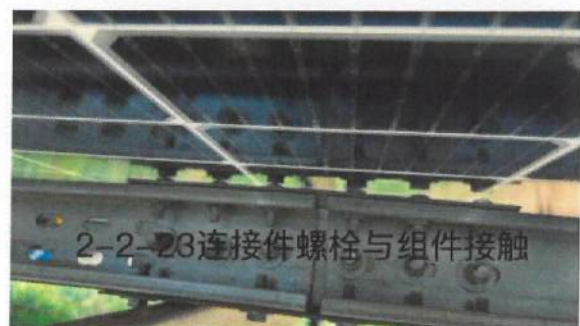
32、连接件螺栓与组件接触
