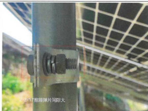
181、抱箍弹片间隙大
