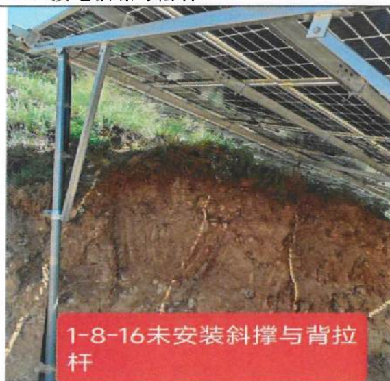
88、未安装斜撑与背拉杆
