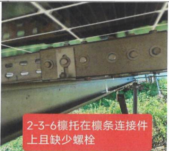
104、檩托在檩条连接件上且缺少螺栓
