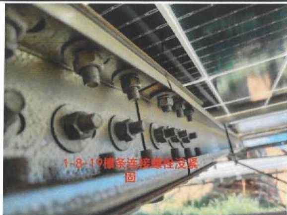
149、檩条连接螺栓没紧固
