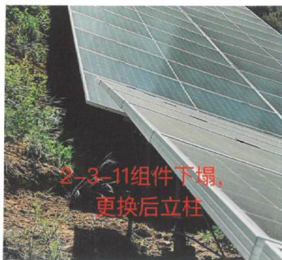
213、组件下塌，更换后立柱
