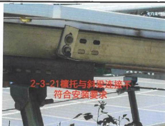
144、標托与斜梁连接不符合安装要求
