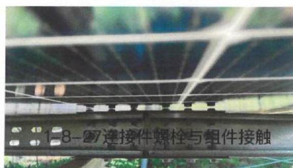
42、连接件螺栓与组件接触
