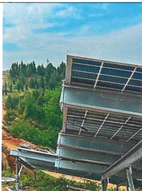
2、檩条侧边长度过短, 边压块不受力
