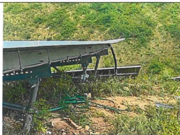
2、檩条侧边长度过短, 边压块不受力
