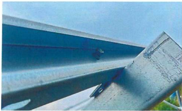
1、 檩托与檩条连接螺栓未紧固
