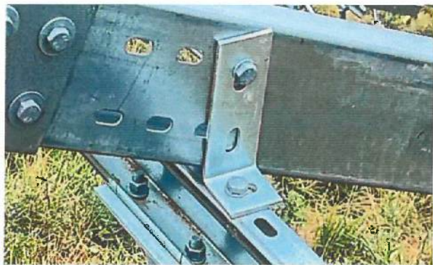
2、 檩托与檩条连接螺栓缺失
