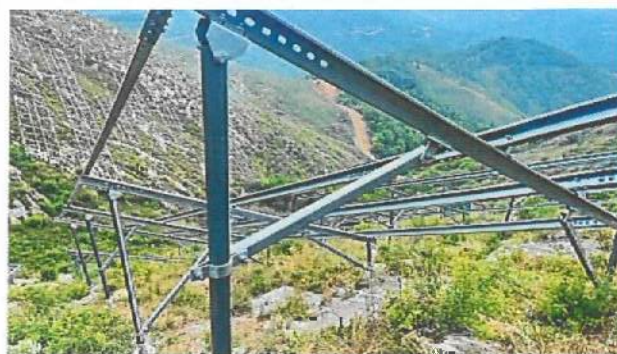
6、后立柱未使用长斜撑
