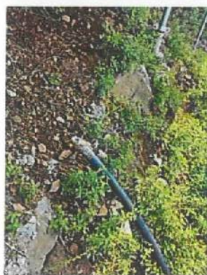
图 3：电缆终端未做保护
