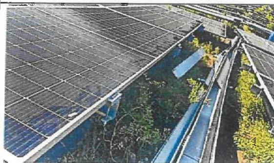
逆变器支架 U 形抱箍锈蚀
