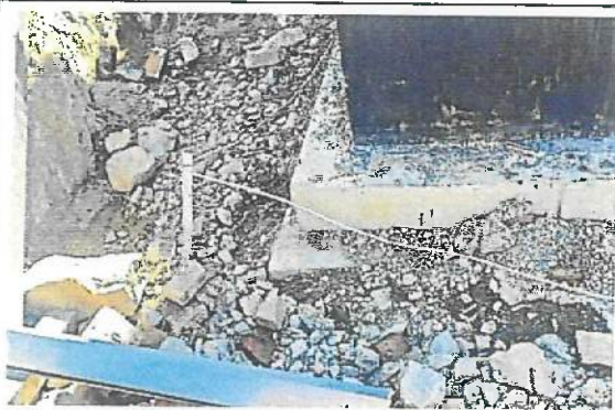
环网接地极埋深不符合要求
