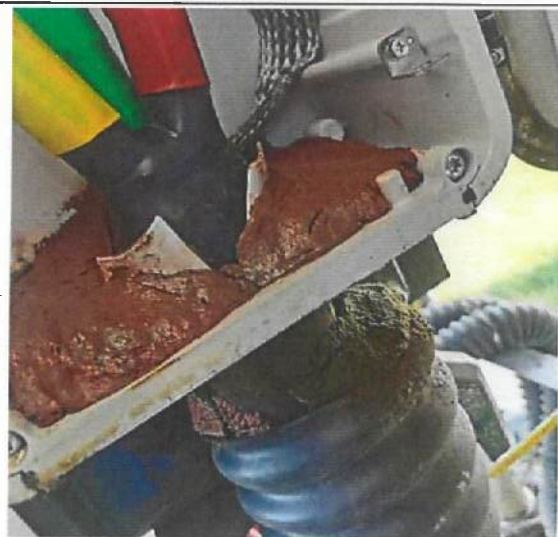
逆变器电缆防火封堵不符合要求
