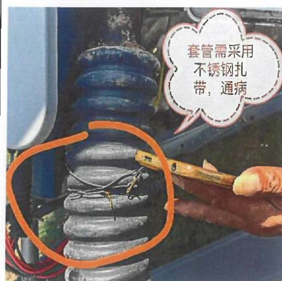
固定套管的扎丝已生锈
