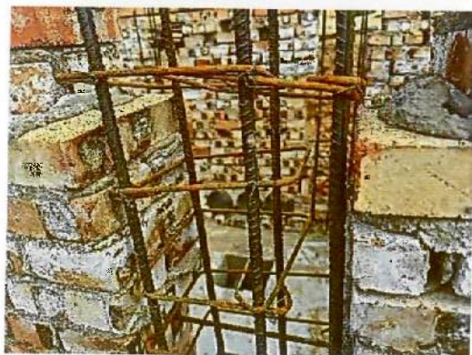
构造柱使用不符合尺寸的箍筋
