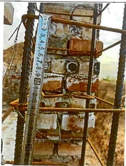
箍筋间距不符合图纸要求
