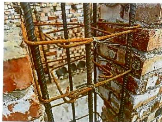
构造柱使用不符合尺寸的箍筋
