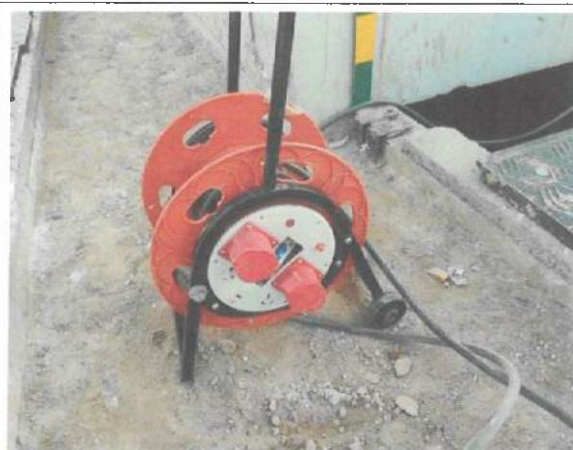
已将临电接头更换为拖线盘
