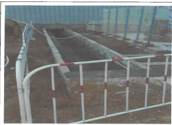
二次舱和生活舱中间电缆沟道围栏已补齐并加固。
