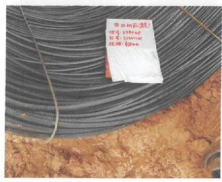
材料堆放区域已做标识牌
