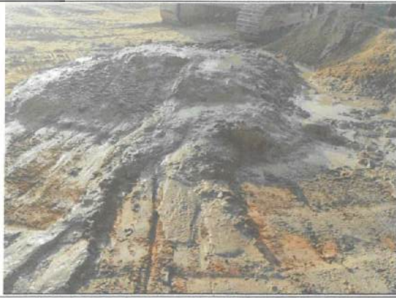
升压站挡墙砂浆重新搅拌使其具有流动性
