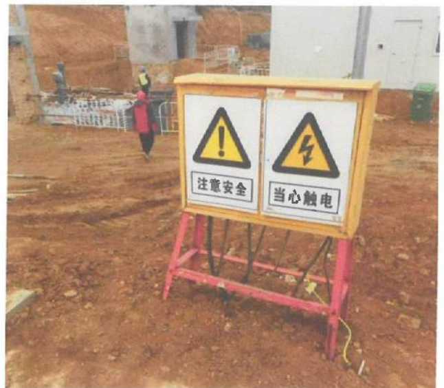
配电箱线路排线已固定
