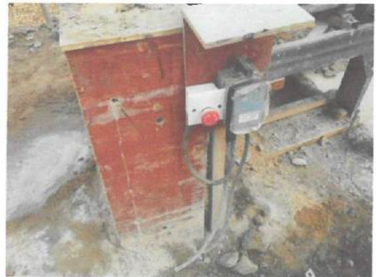
混凝土搅拌机加装急停按钮
