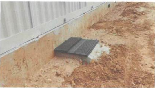
二次舱和生活舱中间电缆沟道围栏已补齐并加固
