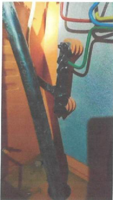
配电箱接地端子已装好保护套
