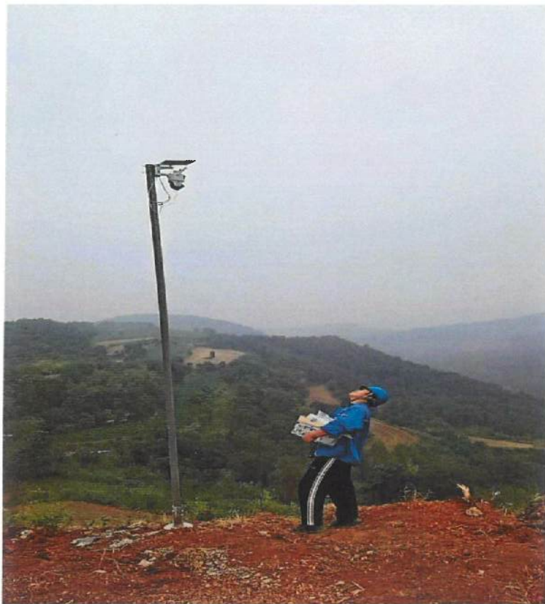
阳朝光伏场区摄像头与落石防护网：
