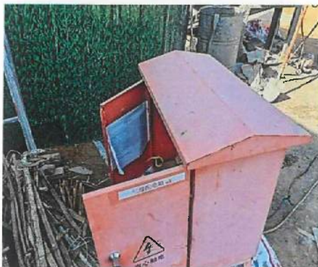
35. 已张贴日检表，并更换接地桩
