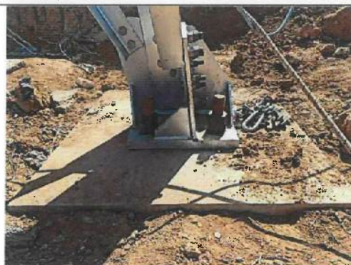
16. 已紧固 AB43 地脚螺栓
