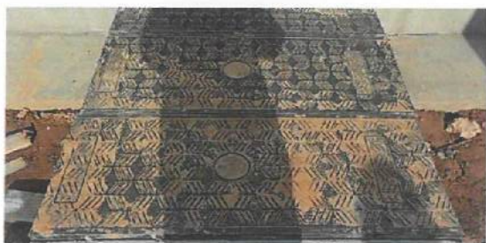
36. 已关闭电缆沟盖板
