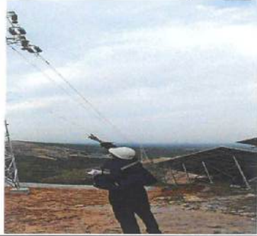
19. AB44-AB45 架线未施工完成，已加强看守
