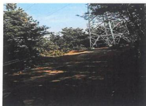
12. 西沟 C8 铁塔处垃圾已进行清理
