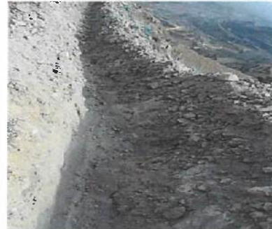
24. 11#开挖电缆沟内垃圾已进行清理
