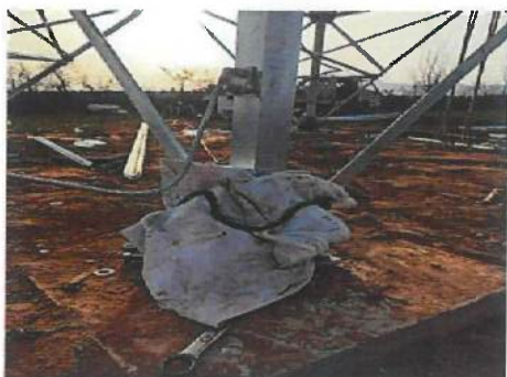
11. 已使用防滑、防磨损措施
