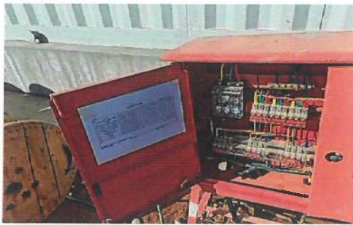
34. 已张贴日检表，并更换接地桩
