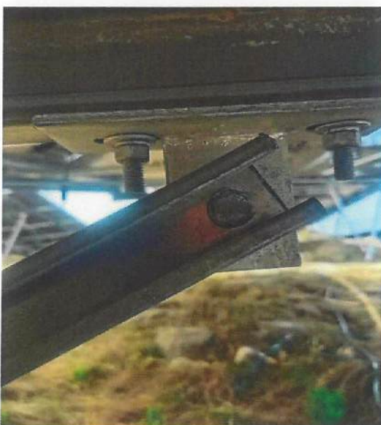
支架斜梁按照规范打眼
