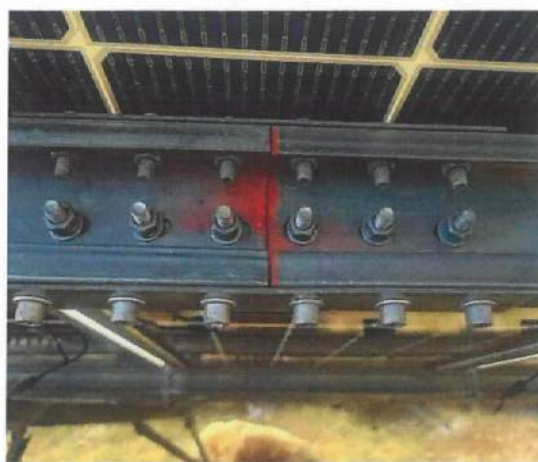
檩条连接缝隙
