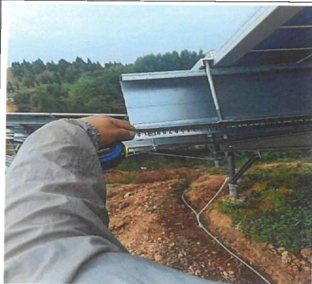
调整后檩条漏出长度
