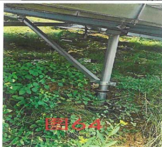
立柱安装处无灌注桩已整改
