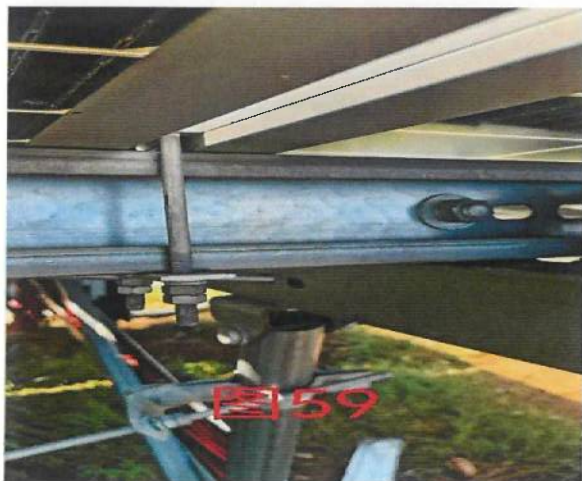
右侧组压块未安装垫片与弹垫已整改
