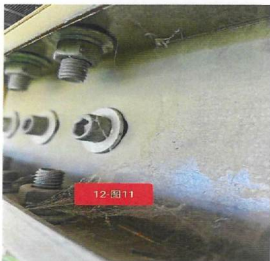
檩条连接件螺丝未紧已整改
