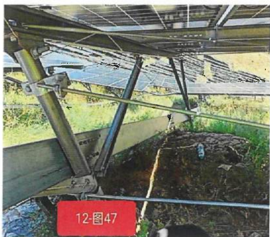
背拉杆未安装已整改
