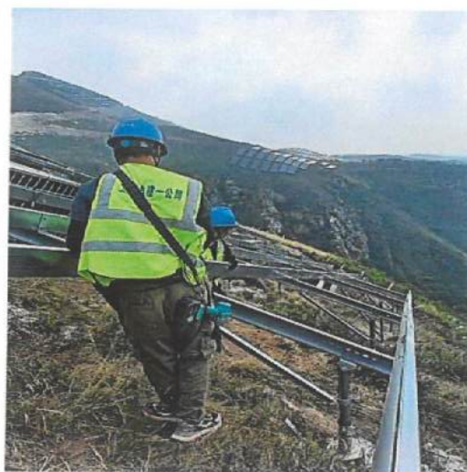
调整位置进行安装
