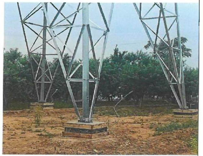
12、送出 G15 塔基保护帽二次浇筑，不符合要求
