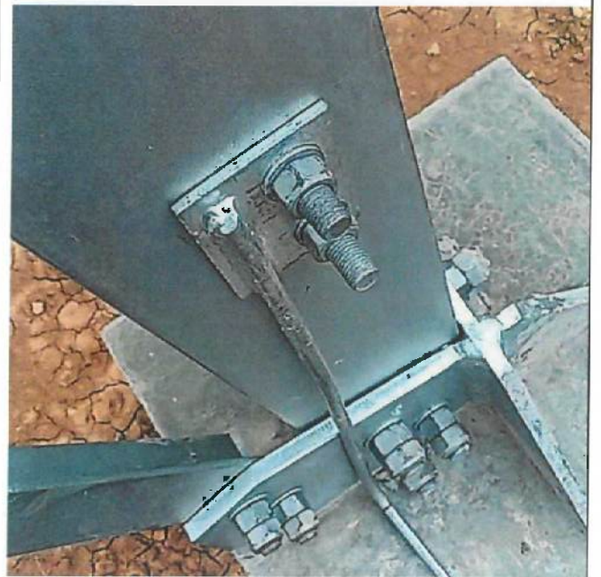
12、送出 G15 塔基保护帽二次浇筑，不符合要求
