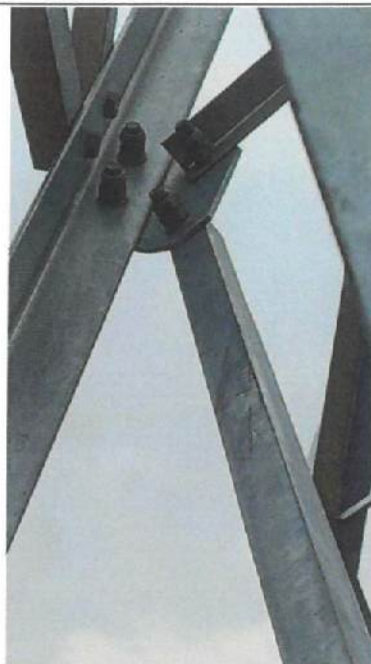
8、送出 G15 塔基螺栓缺少垫片
