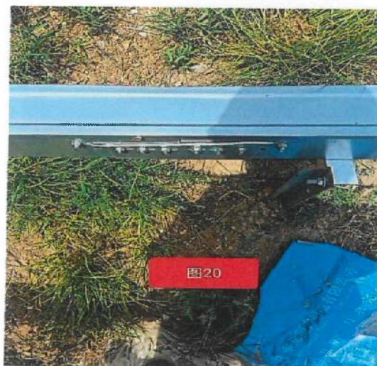
桥架接地未安装已整改
