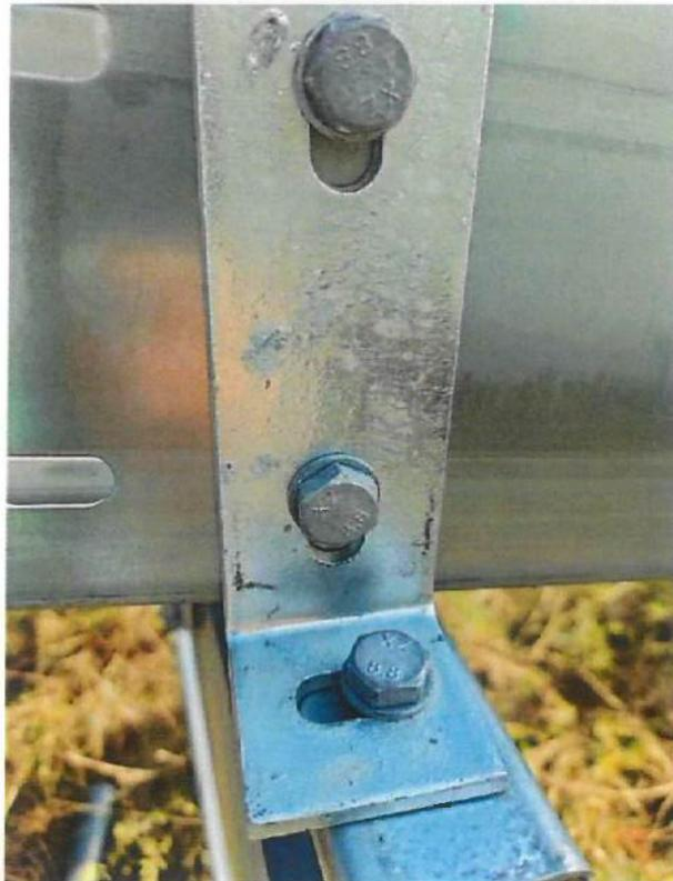
斜梁安装已调整在同一直线
