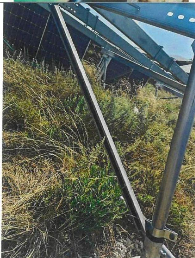
斜撑螺栓已紧固
