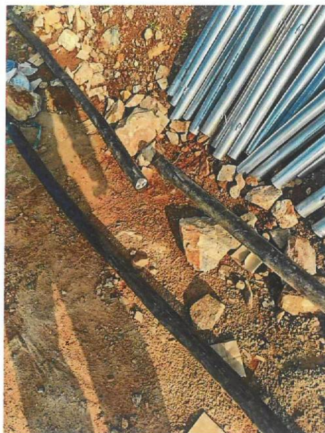
现场剪除破损部位
