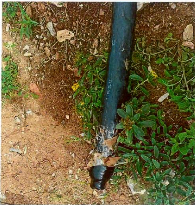
电缆绝缘层处理
