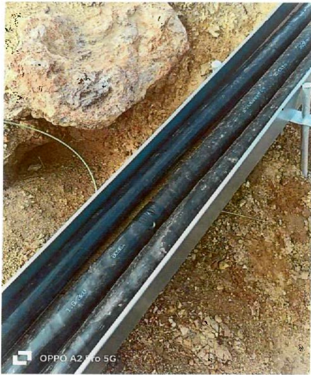
电缆绝缘层处理
