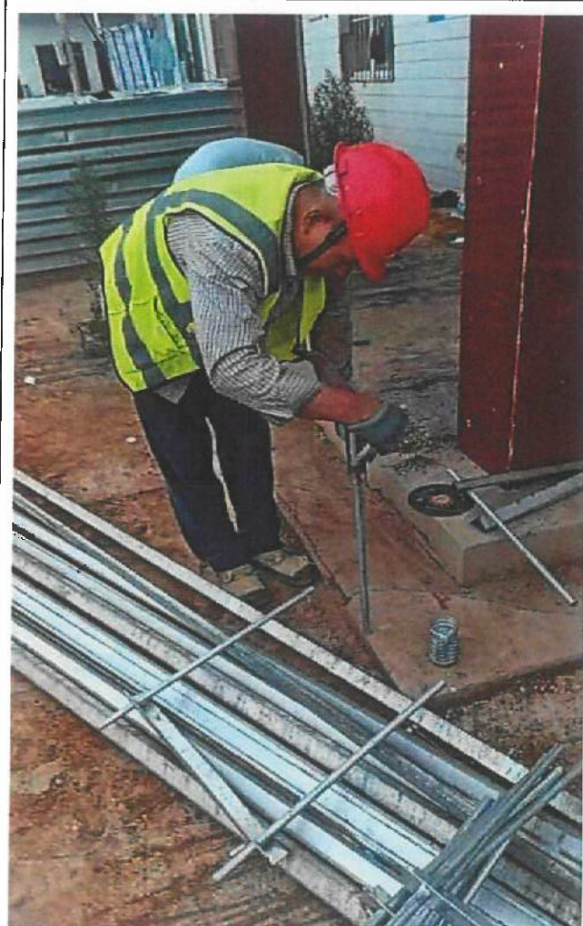
桥架支架防腐处理
