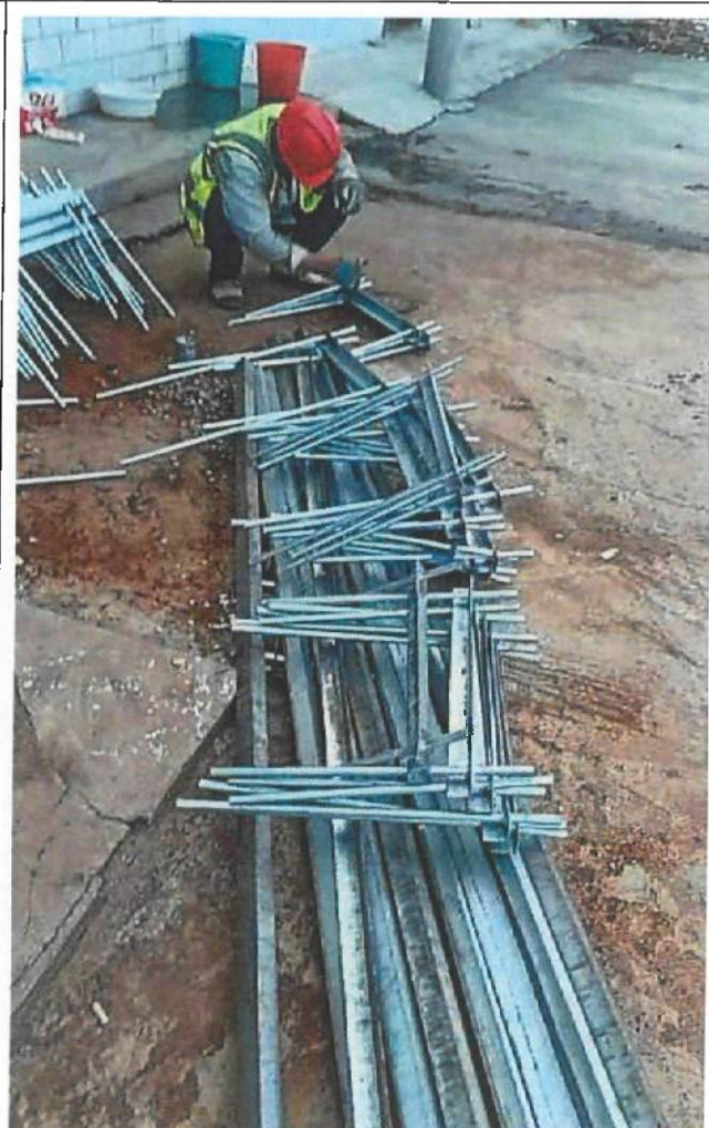
桥架支架防腐处理
