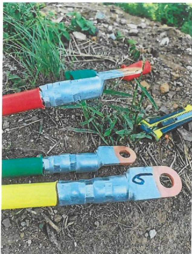
电缆头打磨完成
