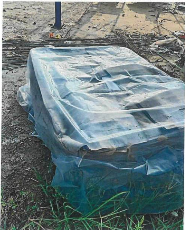
图 1 高压电缆头已进包扎垫高
