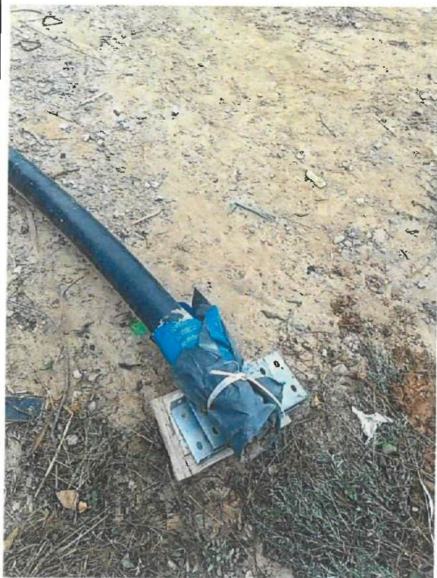
图 1 高压电缆头已进包扎垫高
