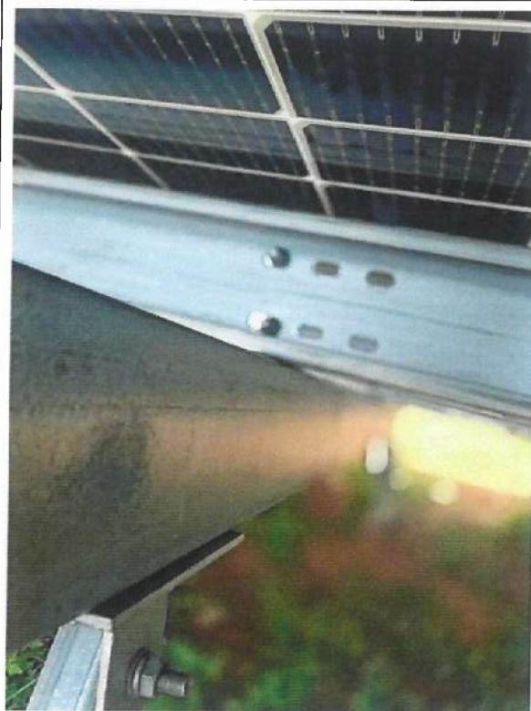
6 檩条与斜梁连接处已处理
