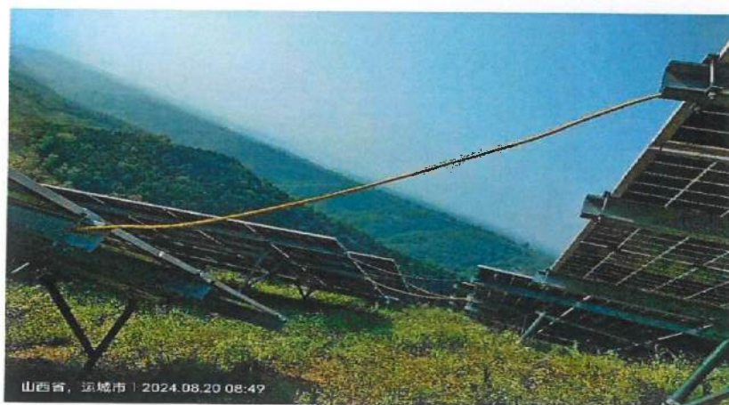
9、组件，阵列接地连接线已安装
