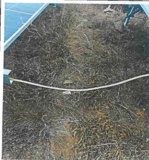
32 两组件间跨接线安装
