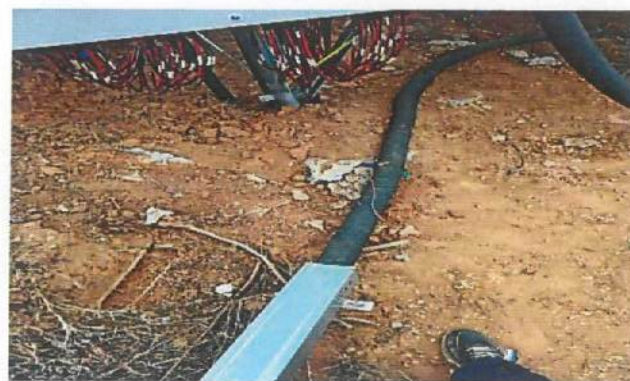
44 逆变器旁电缆已制作桥架
