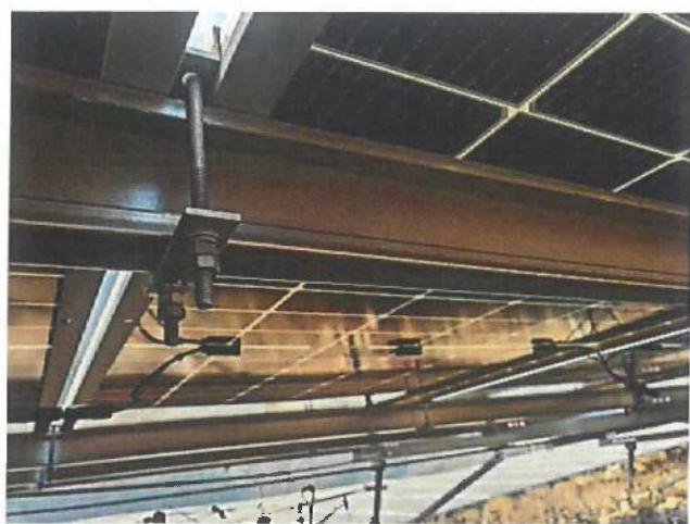
13 弯曲檩条已更换
