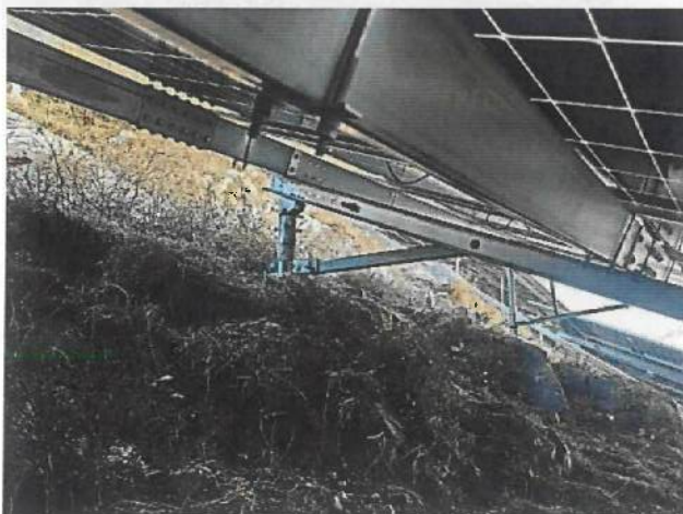
25 斜撑安装已调整
