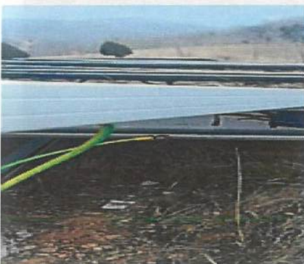
37 组件短接安装
