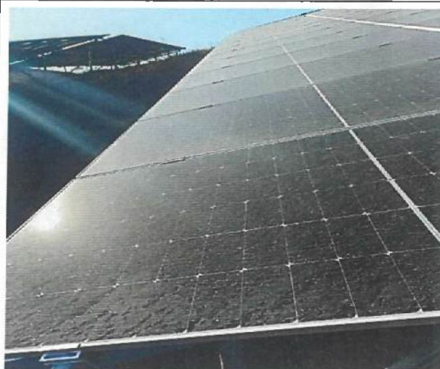
20 损坏组件已更换
