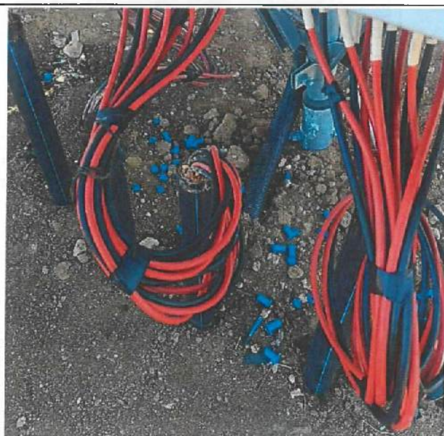
15 损坏套管已更换
