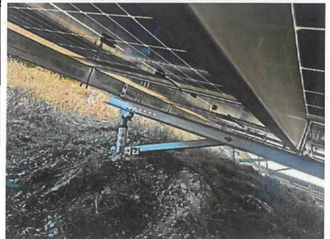
26 斜撑安装已调整
