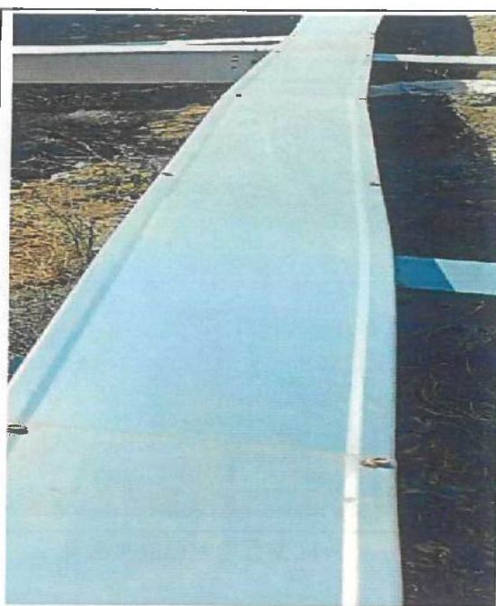
18 电缆已用桥架安装
