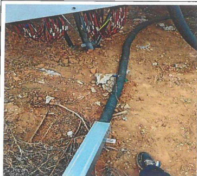
39 逆变器边电缆进行地埋及桥架
