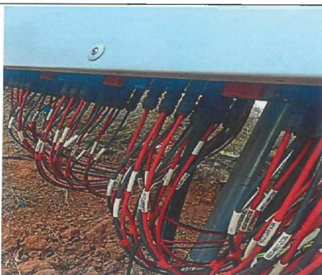
41 直流电缆制作电缆头
