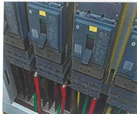
4 箱变内部垃圾已清理
