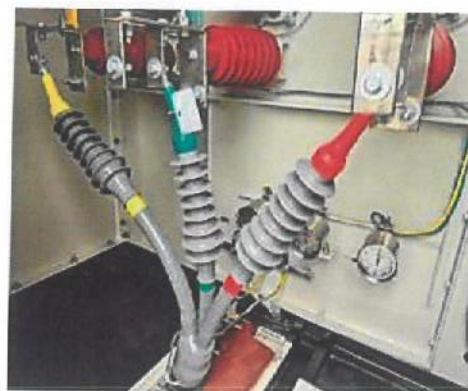
6 高压电缆封堵，垃圾清理
