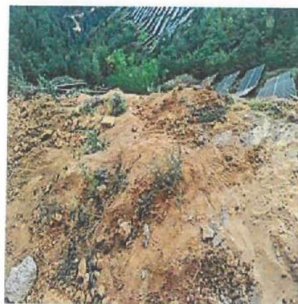
16 废弃电缆已清理
