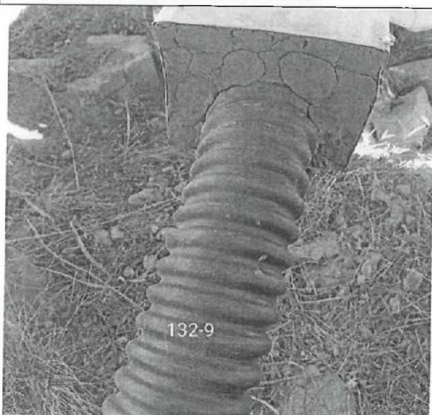
9 桥架封堵已整改
