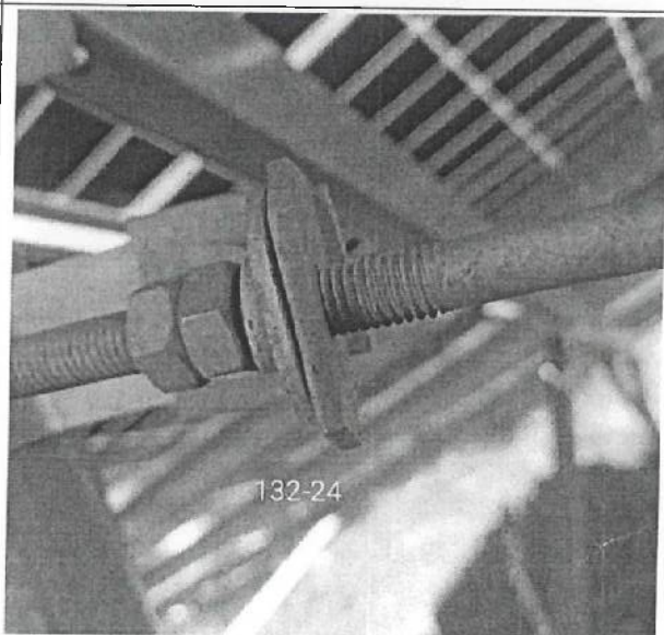
24 拉杆过长螺丝无法紧已整改
