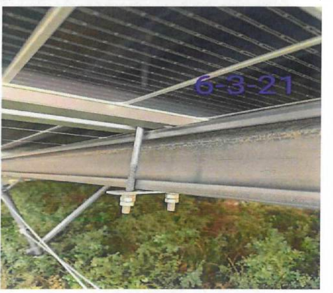
12 压块螺栓拧紧
