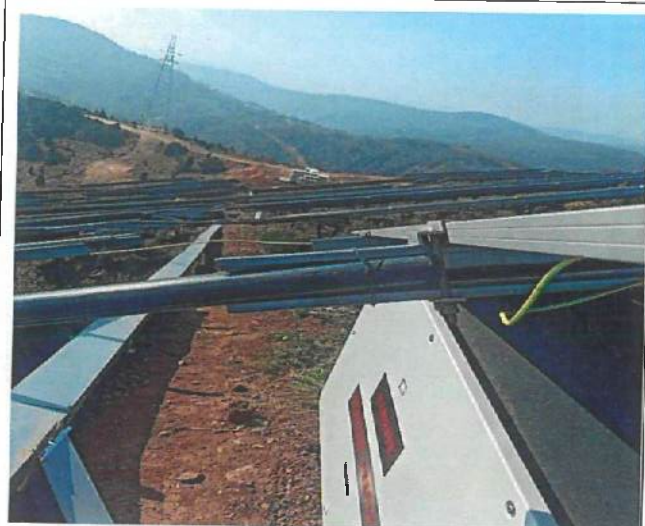
25 电缆套管绑扎
