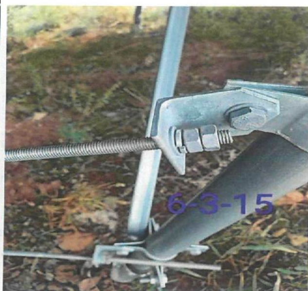
2 拉杆螺栓拉紧
