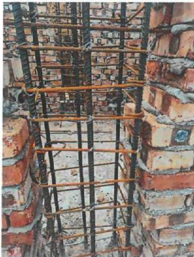
构造柱钢筋扎满
