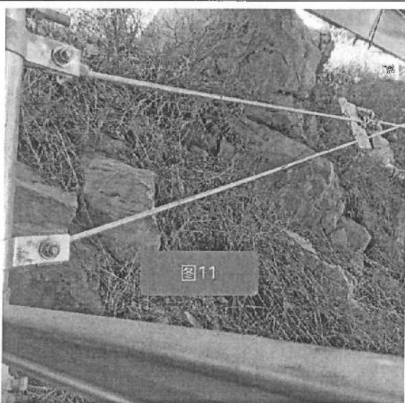
图11 拉杆需要更换位置已整改
