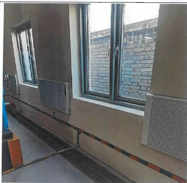
3、水泵房电暖器加装
