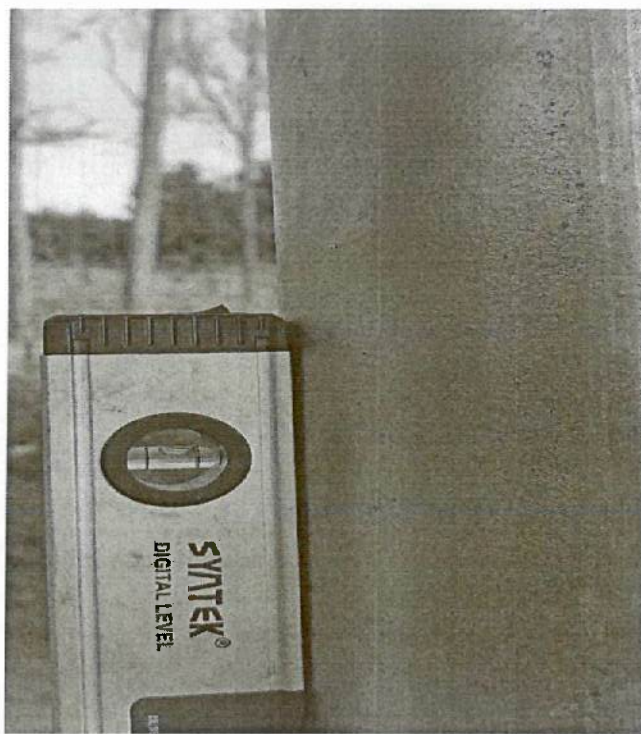
立柱角度调整已整改
