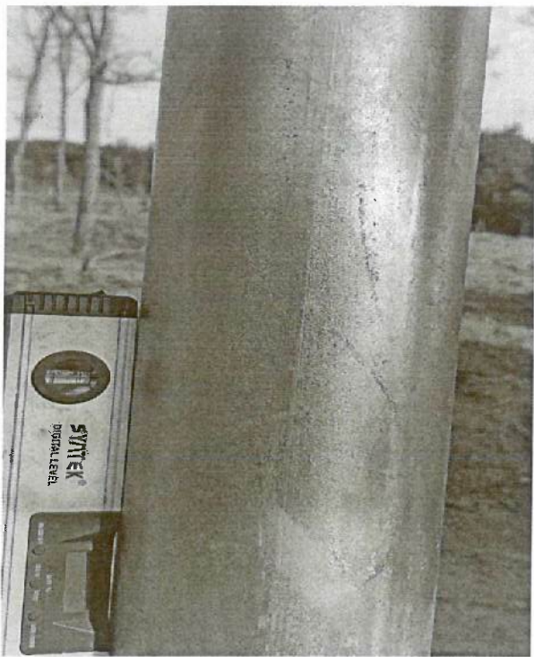
立柱角度调整已整改
