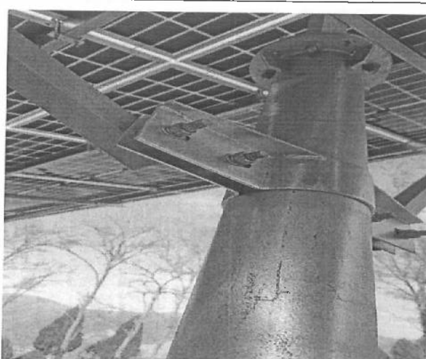
2 抱箍已调整安装牢固
