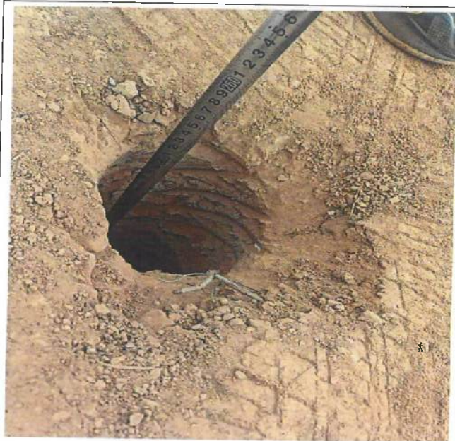
1 桩孔深度已调整
