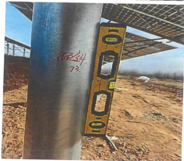
立柱傾斜已整改
