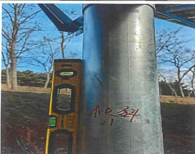
立柱倾斜已整改
