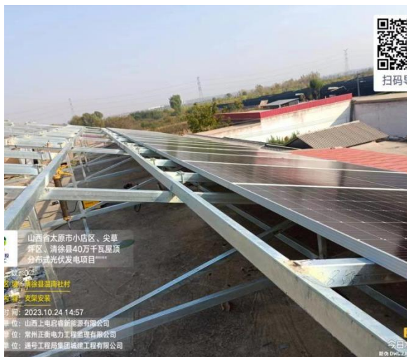
地脚板小、未使用化学锚栓、未满焊
