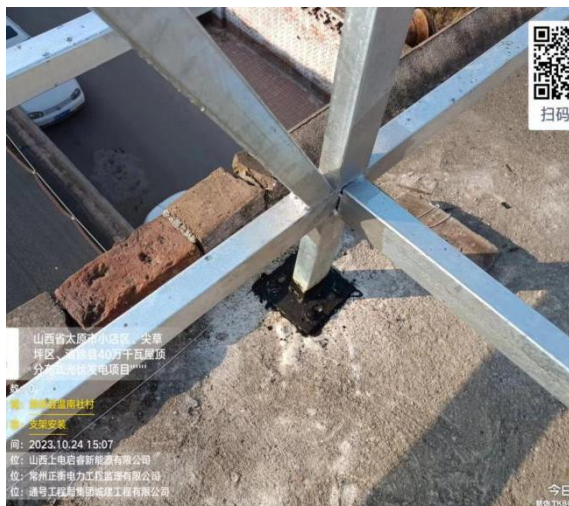
地脚板小、未使用化学锚栓、未满焊
