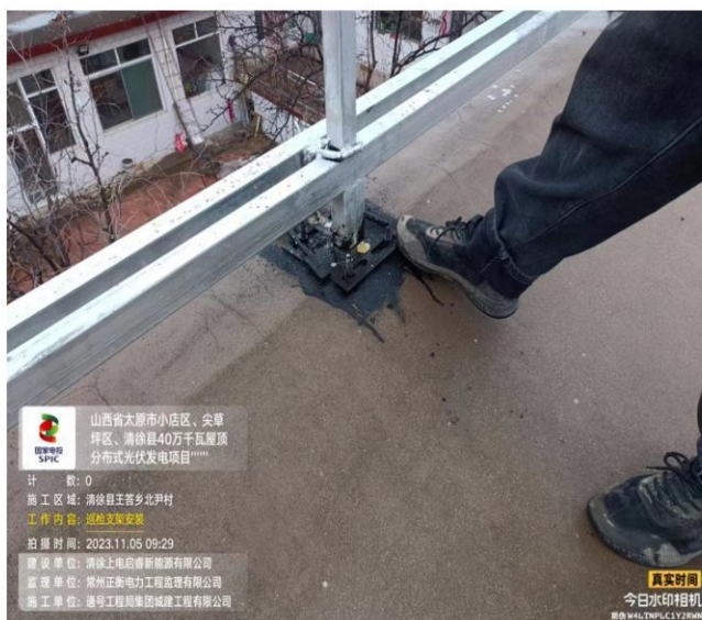
南北墙膨胀螺栓不符合图纸设计要求
