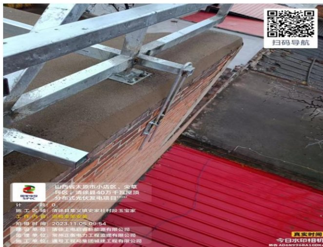
固定拉筋长度不足、焊接不符合设计要求
