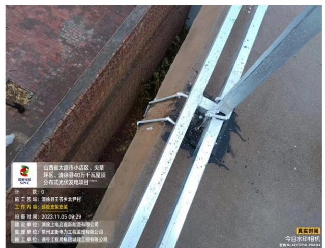
固定拉筋长度不足、焊接不符合设计要求
